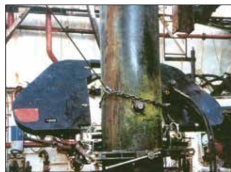
▼ Trabajo de desmantelamiento con sierra de banda.
