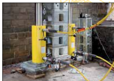
Elevación y tendido de puente
