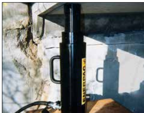
◀ El cilindro portátil con contratuerca RACL1506 utilizado para soporte de carga durante largo tiempo durante inyección de epoxi para refuerzo de puente.
