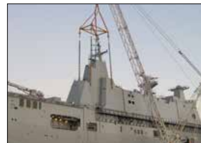
Elevación y colocación sincrónicas de carga
