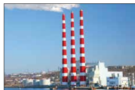
Generación de electricidad
