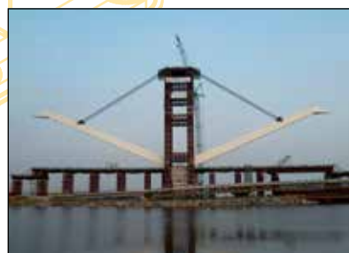
Elevación mediante gato con control preciso de alta capacidad
