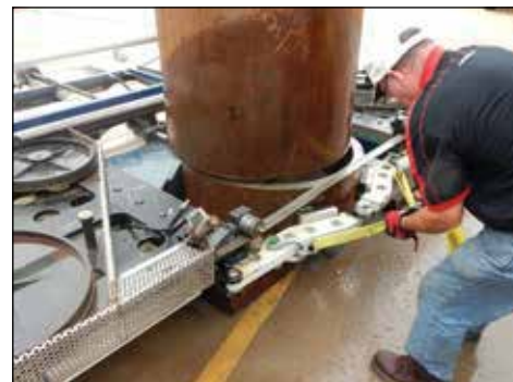
▲ Corte de tubería con sierra de banda portátil BS.
