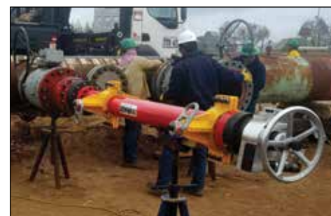
▲ Aplicación de roscado en servicio de la CHT3000 para la instalación de una tubería petroquímica.
