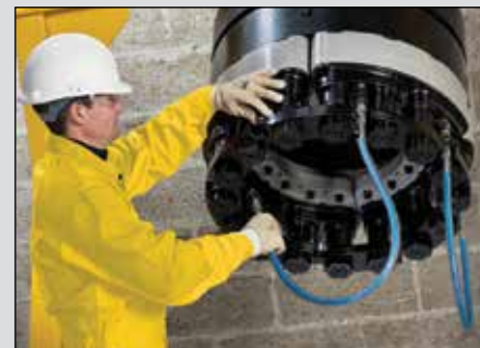
▲ Aplicación del tensado de múltiples tornillos.
