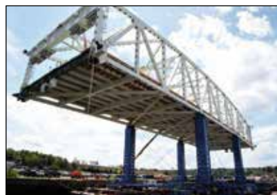
Elevación de puente en incrementos
