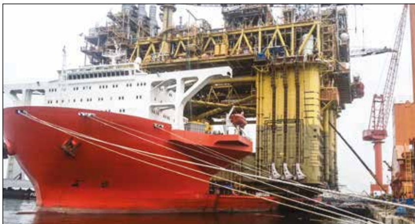
▲ La elevación y el lanzamiento de un sistema flotante de producción de petróleo de 43.000 ton. para el yacimiento petrolífero marítimo (off shore) Gurnusut-Kakap en Malasia, estableció unos valores de referencia muy altos para la seguridad, gracias al uso de sofisticados sistemas hidráulicos sincronizados para la elevación, el equilibrio, el pesaje y la botadura suave de estructuras pesadas.
