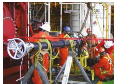
▼ Aplicación de hot tapping en alta mar con CHT2000.
