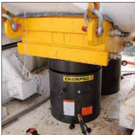
▲ Elevación de cargas pesadas y nivelación de cimentación. La tuerca de bloqueo proporciona una retención mecánica de la carga durante un tiempo prolongado.
