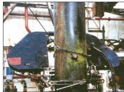
▼ Trabajos de desmantelamiento con sierra de cinta.
