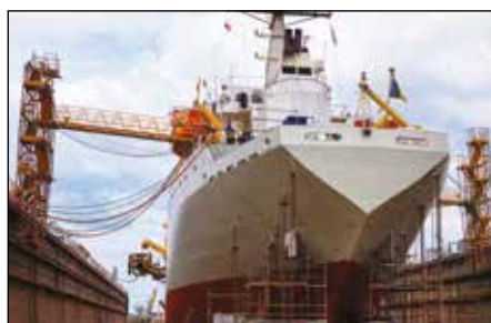
Construcción, Mantenimiento y Reparación de buques
