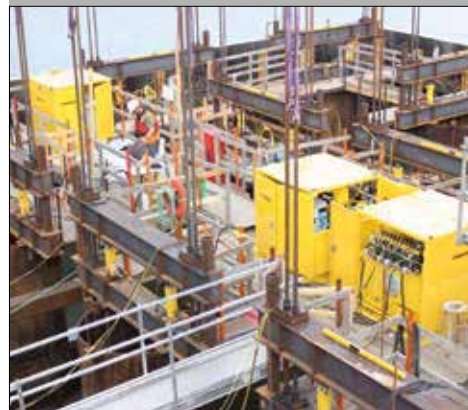
▲ Bomba hidráulica personalizada para un sistema de tendido de tablero de puente.
