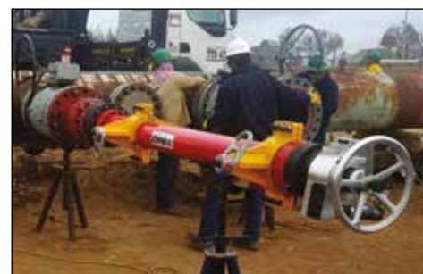
▲ Aplicación de hot tapping con CHT3000 para la instalación de oleoductos petroquímicos.
