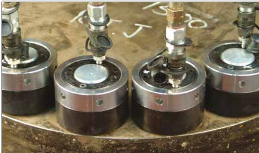
▲ Tensionado con tuercas hidráulicas.
